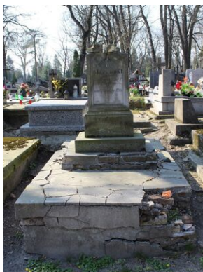
Grób przed remontem. Fot. Sylwia Kostyra/IPN Lublin
