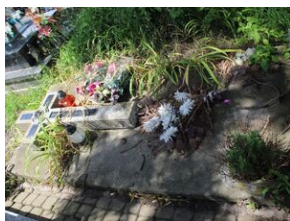
Grób ppor. Kostrzewskiego przed remontem. Fot. Sylwia Kostyra/IPN Lublin
