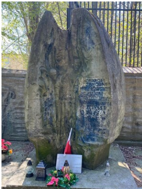
Stan przed remontem. Fot. Wykonawca remontu.
